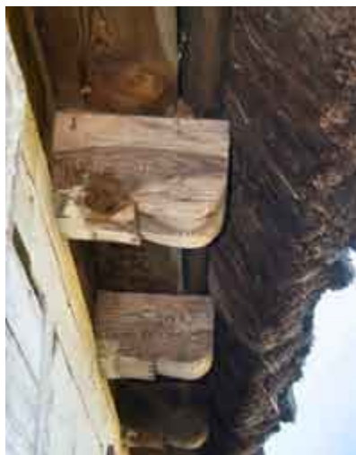
Wystające belki stropowe do mocowania dachu we wsi Wierzchy
