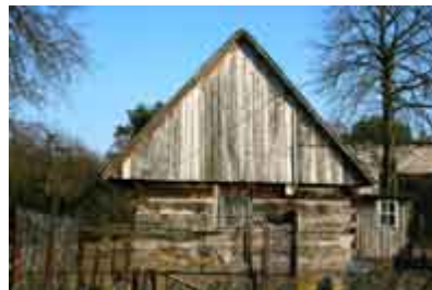
Ściana szczytowa obita deskami w układzie pionowym, wieś Stary Borowiec
