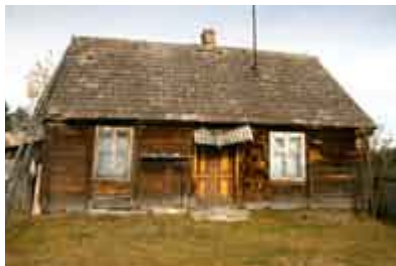
Dach kryty dachówką we wsi Zamęty
