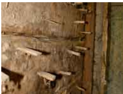
Kołki wbite w łątki do podtrzymania glinianego tynku we wsi Wierzchy
