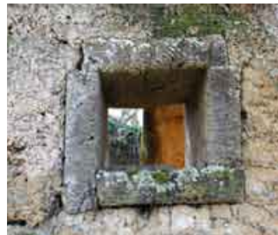
Okienko w budynku gospodarczym
