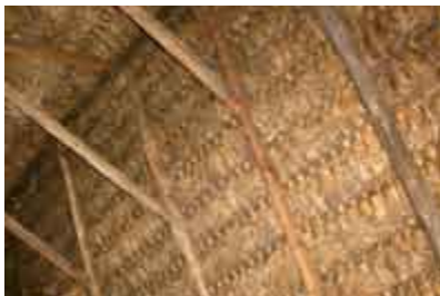
Ręczne wiązanie słomy na dach, wieś Wojciechów
