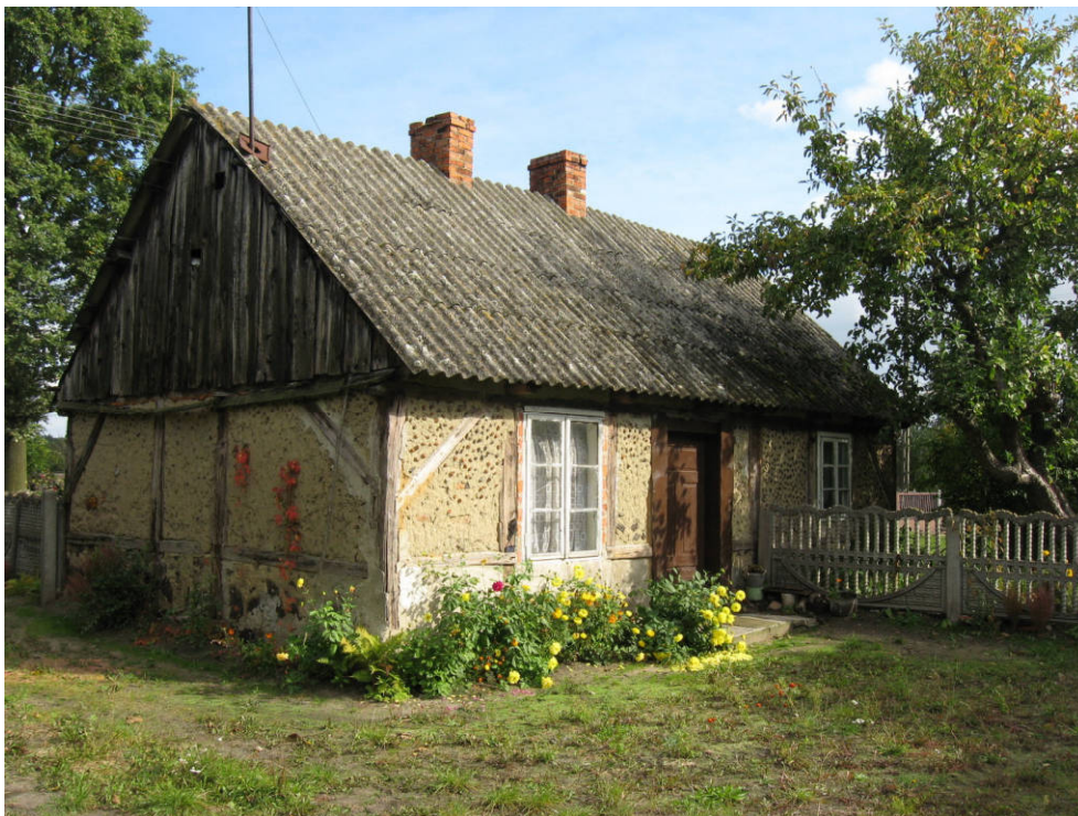
17. Budynek mieszkalny - fot. 2009, fot. Patrycja Mikołajczak.
