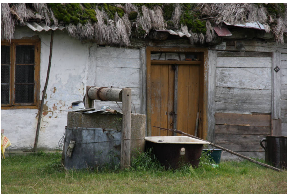
133. Mała architektura - studnia - fot. 2009, fot. Piotr Szwiec.
