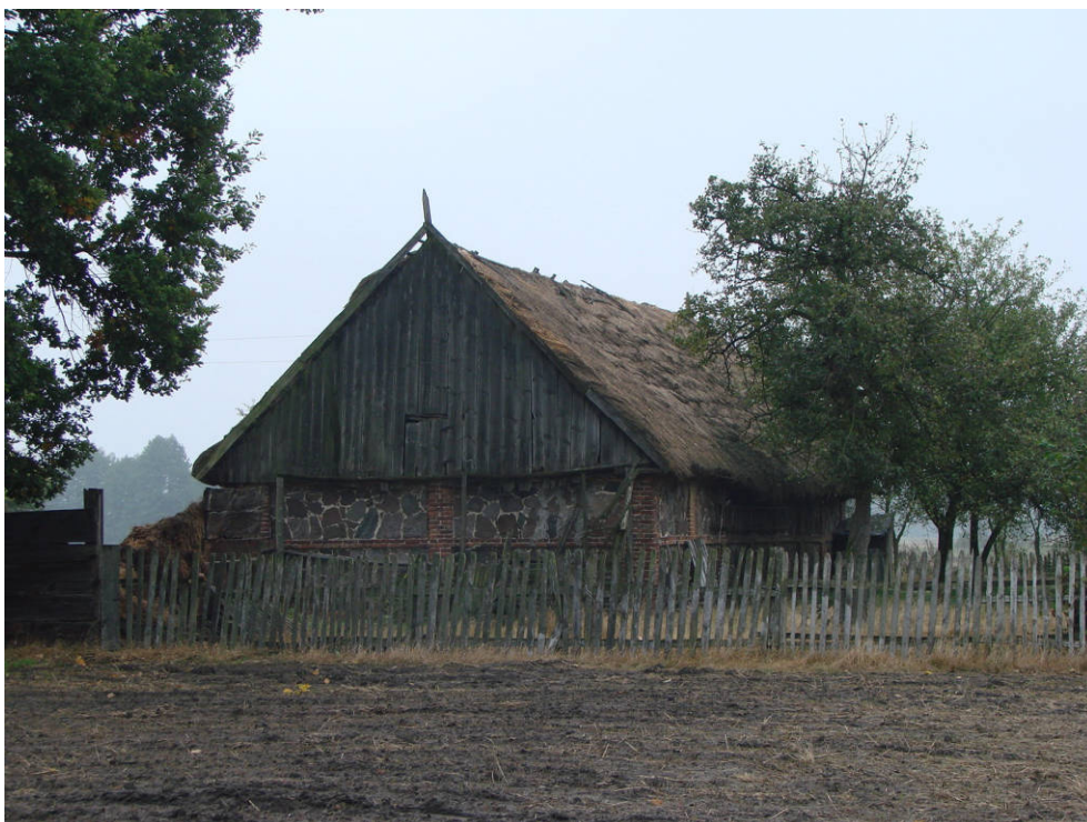
85. Budynek gospodarczy - fot. 2009, fot. Witold Przewoźny.
