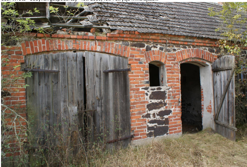
116. Wrota i drzwi - budynek gospodarczy - fot. 2009, fot. Bartosz Stańda.
