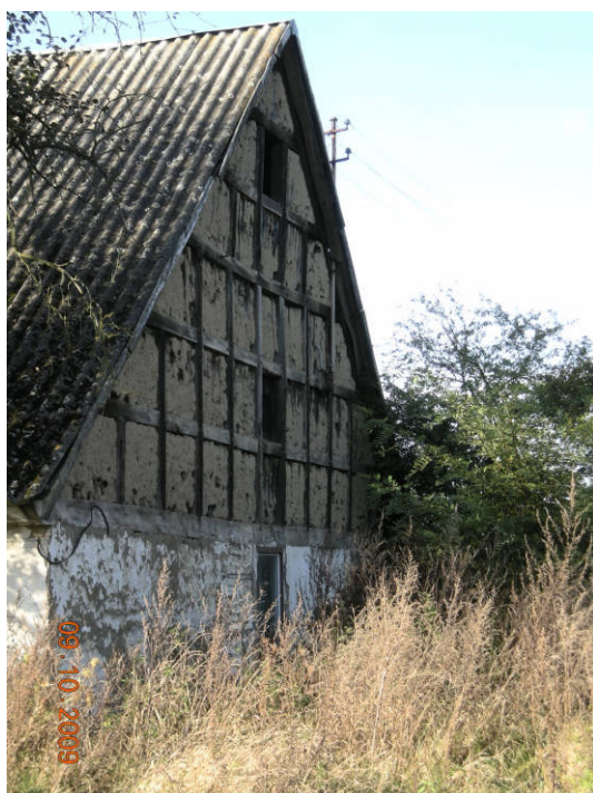
40. Budynek mieszkalny – szczyt – konstrukcja szachulcowa - fot. 2009, fot. Paulina Baranowska.
