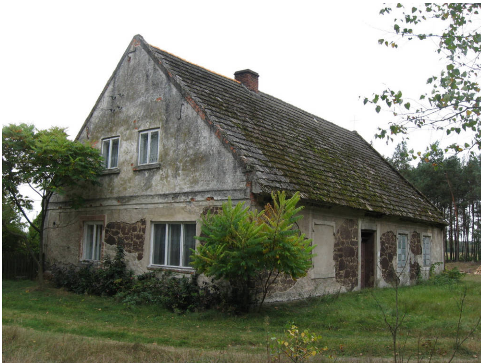
31. Budynek mieszkalny - fot. 2009, fot. Patrycja Mikołajczak.
