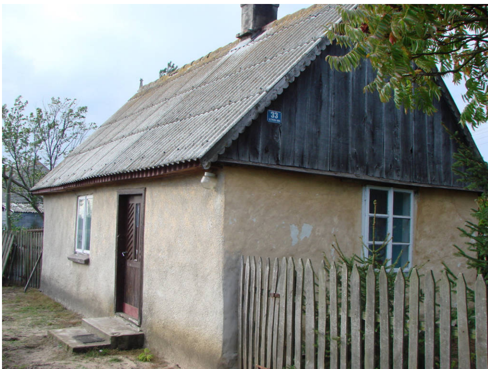
23. Budynek mieszkalny - fot. 2009, fot. Witold Przewoźny.
