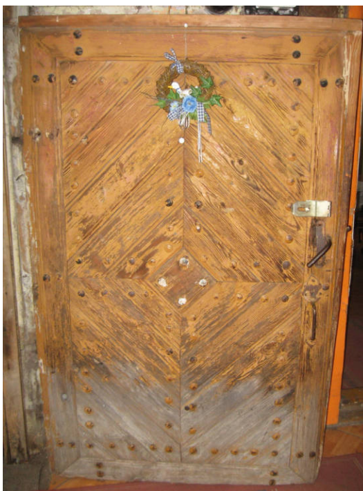
63. Drzwi wejściowe - budynek mieszkalny - fot. 2009, fot. Patrycja Mikołajczak.
