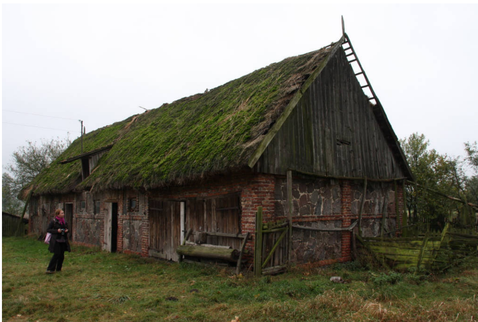
83. Budynek gospodarczy - fot. 2009, fot. Piotr Szwiec.
