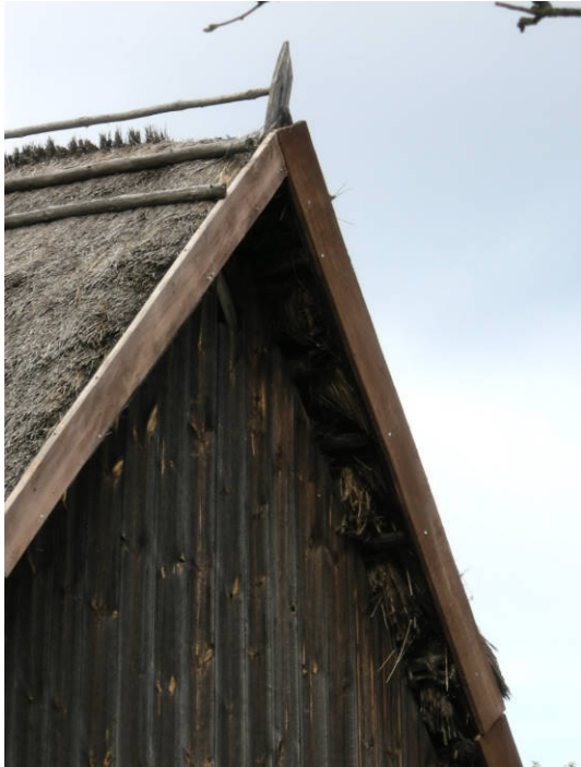
2. Budynek mieszkalny - szczyt - fot. 2009, fot. Paulina Baranowska.
