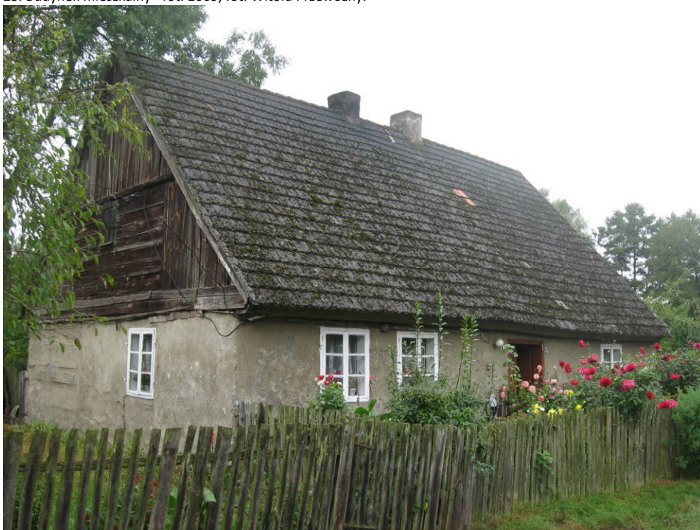
24. Budynek mieszkalny - fot. 2009, fot. Patrycja Mikołajczak.
