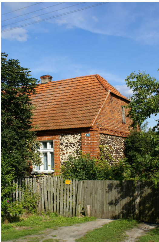
35. Budynek mieszkalny - fot. 2009, fot. Anna Weronika Brzezińska.
