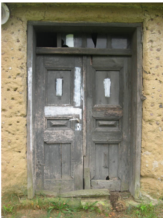
57. Drzwi wejściowe - budynek mieszkalny - fot. 2009, fot. Patrycja Mikołajczak.
