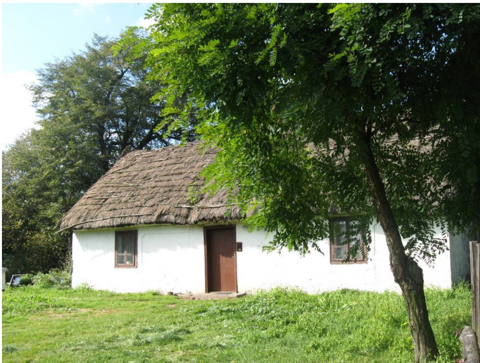
21. Budynek mieszkalny - fot. 2009, fot. Patrycja Mikołajczak.
