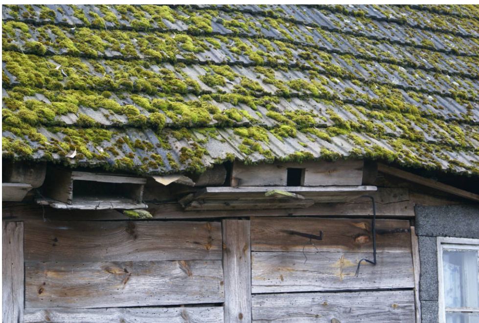
5. Budynek mieszkalny - detal dachu - fot. 2009, fot. Anna Weronika Brzezińska.
