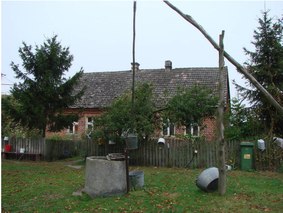
39. Budynek mieszkalny - fot. 2009, fot. Witold Przewoźny.
