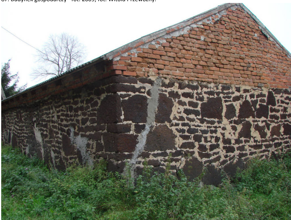
88. Budynek gospodarczy - fot. 2009, fot. Witold Przewoźny.
