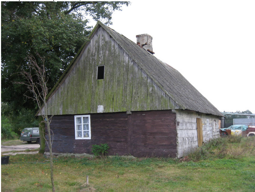
11. Budynek mieszkalny - fot. 2009, fot. Patrycja Mikołajczak.
