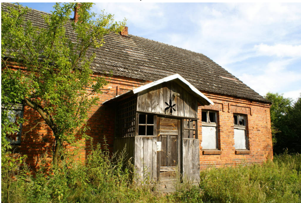
73. Ganek - budynek mieszkalny - fot. 2009, fot. Anna Weronika Brzezińska.
