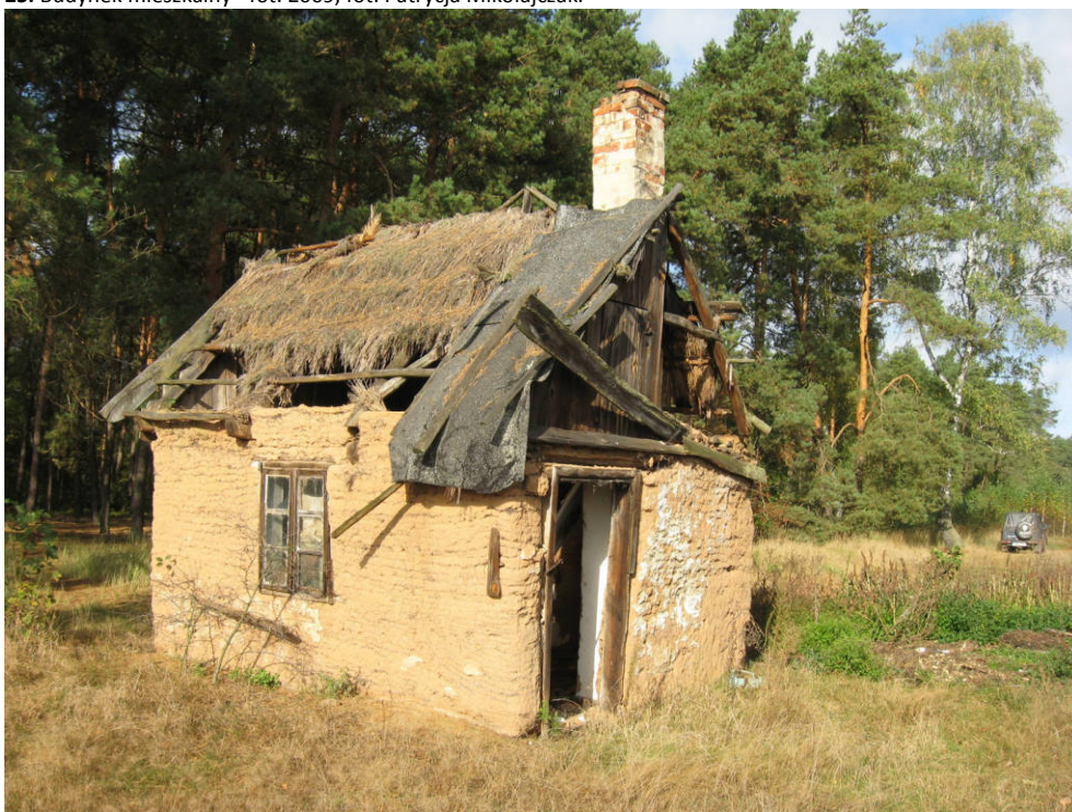
26. Budynek mieszkalny - fot. 2009, fot. Patrycja Mikołajczak.
