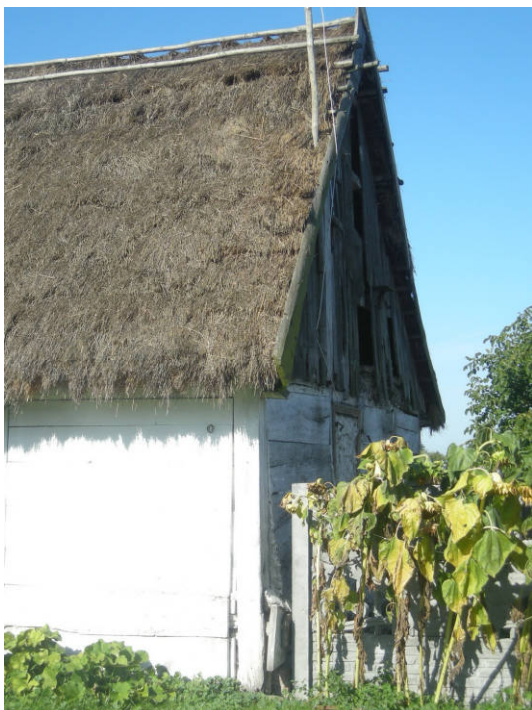
1. Budynek mieszkalny - szczyt - fot. 2009, fot. Paulina Baranowska.
