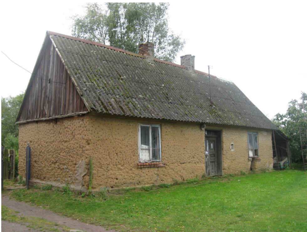
25. Budynek mieszkalny - fot. 2009, fot. Patrycja Mikołajczak.
