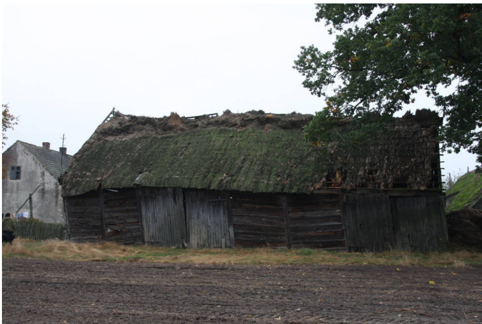
79. Budynek gospodarczy - fot. 2009, fot. Piotr Szwiec.
