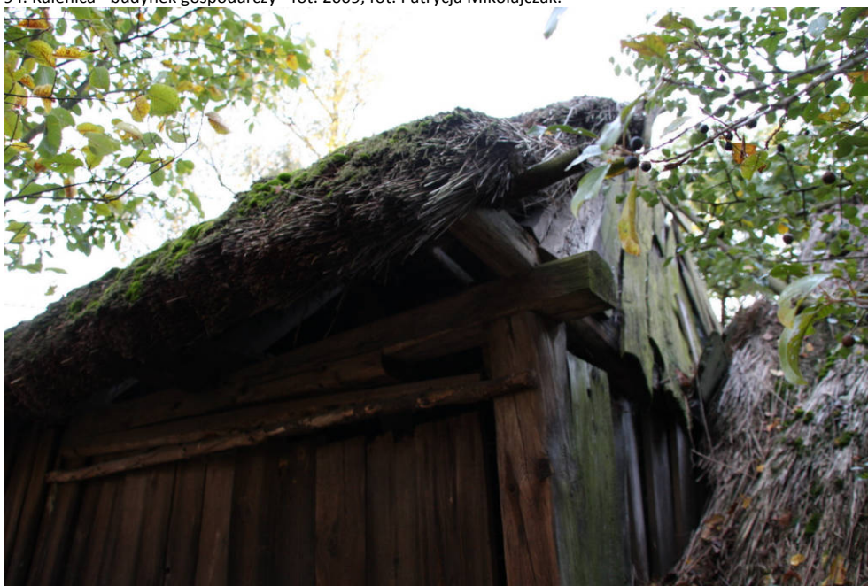
95. Okap - budynek gospodarczy - fot. 2009, fot. Patrycja Mikołajczak.
