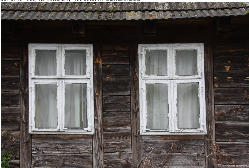
52. Okno - budynek mieszkalny - fot. 2009, fot. Piotr Szwiec.
