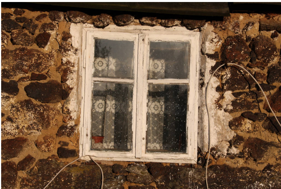
49. Okno - budynek mieszkalny - fot. 2009, fot. Piotr Szwiec.
