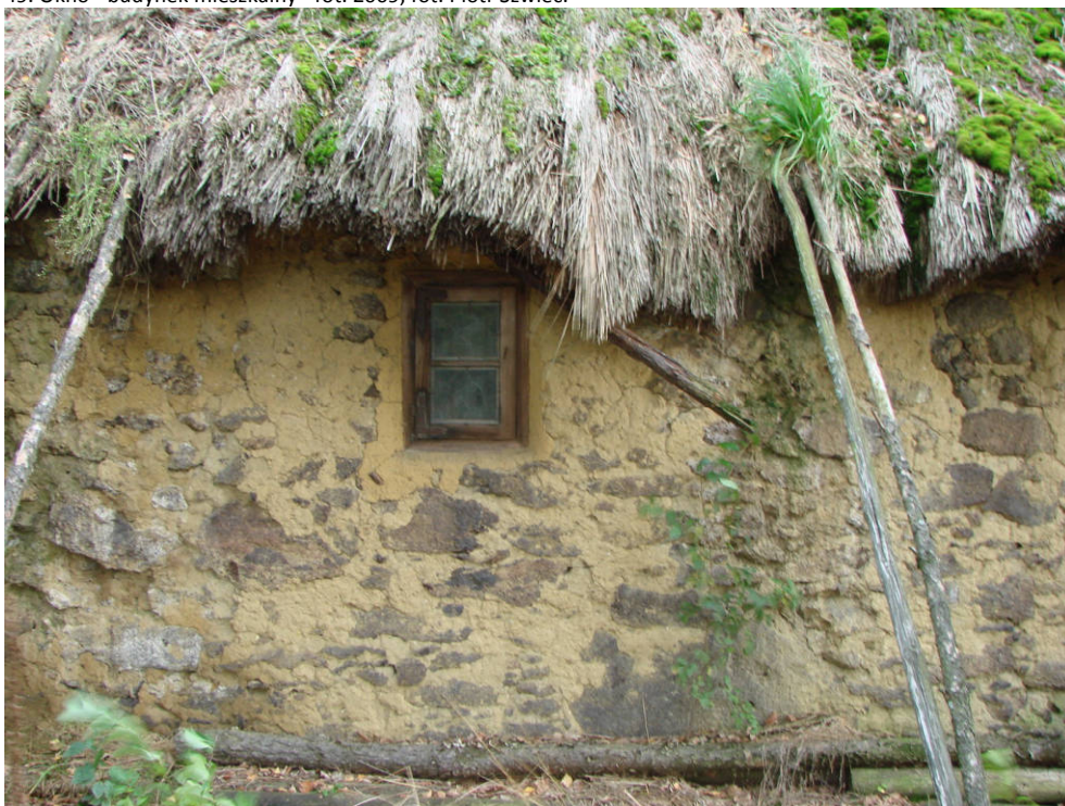
50. Okno - budynek mieszkalny - fot. 2009, fot. Witold Przewoźny.
