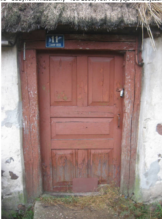
64. Drzwi wejściowe - budynek mieszkalny - fot. 2009, fot. Patrycja Mikołajczak.
