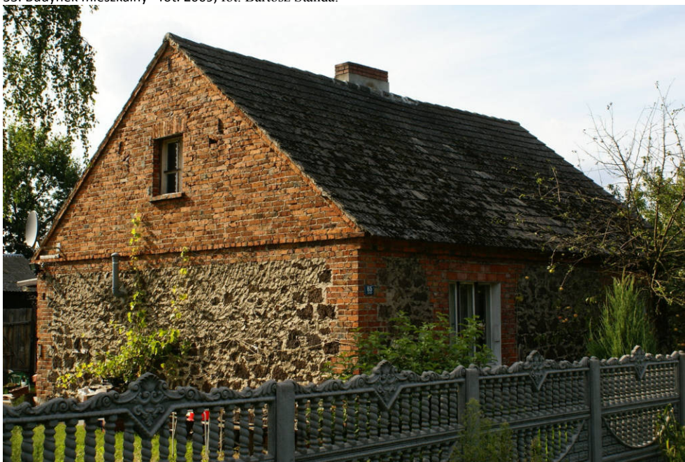
34. Budynek mieszkalny - fot. 2009, fot. Anna Weronika Brzezińska.
