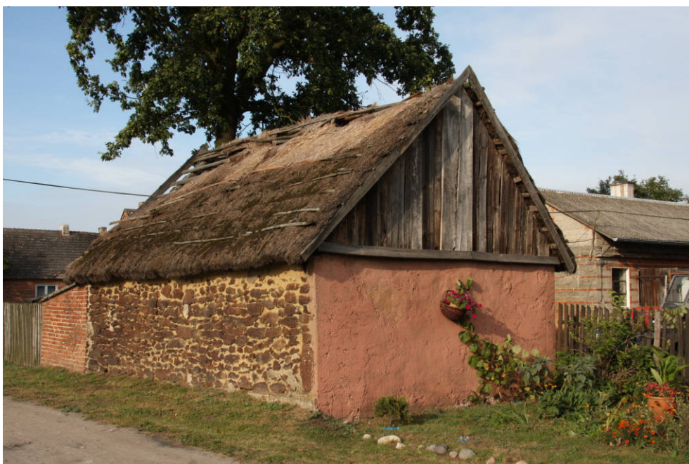
91. Budynek gospodarczy - fot. 2009, fot. Piotr Szwiec.
