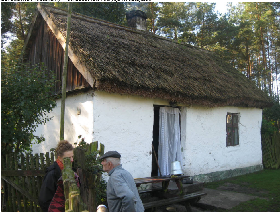
22. Budynek mieszkalny - fot. 2009, fot. Patrycja Mikołajczak.
