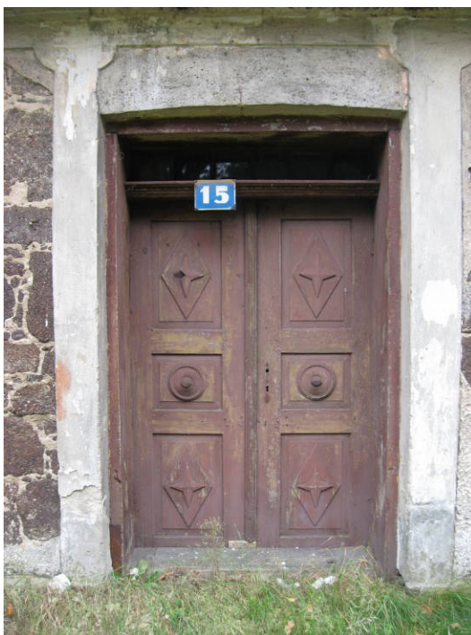
55. Drzwi wejściowe - budynek mieszkalny - fot. 2009, fot. Patrycja Mikołajczak.
