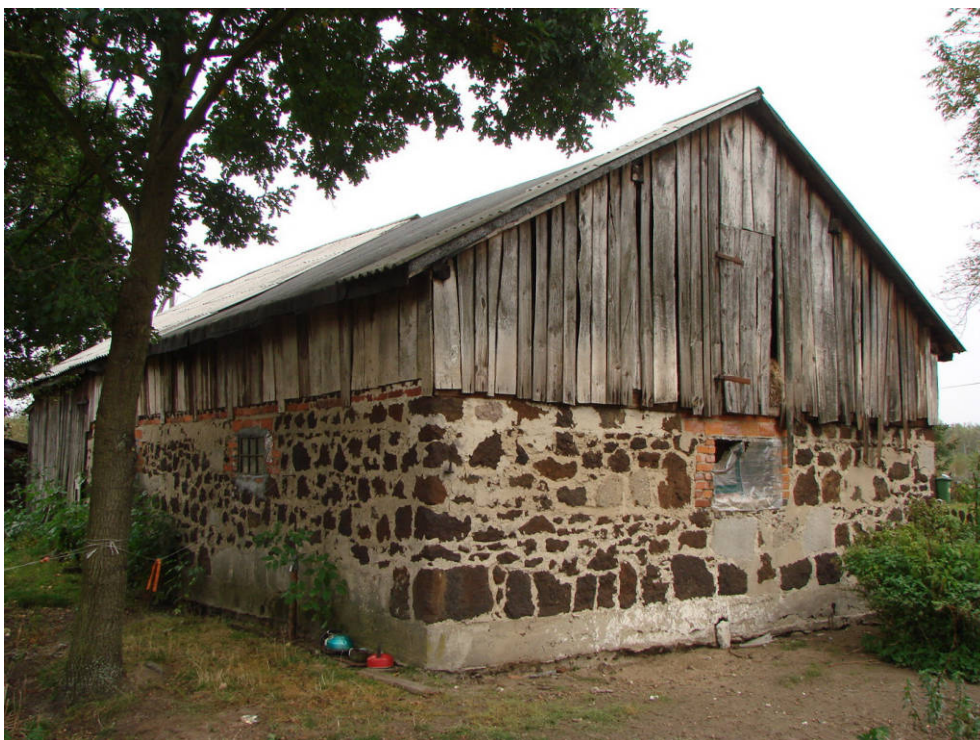
87. Budynek gospodarczy - fot. 2009, fot. Witold Przewoźny.
